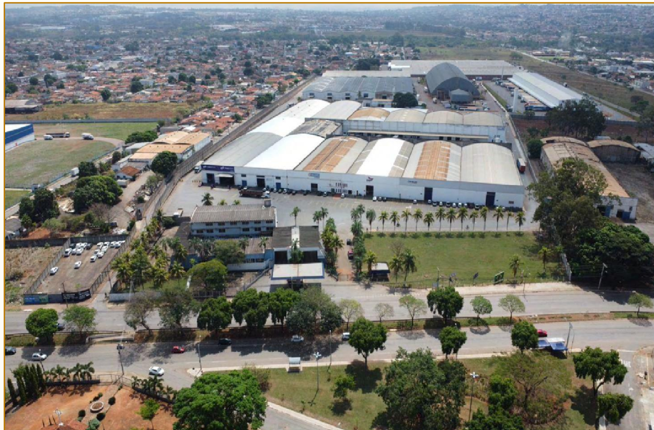
Complexo logístico da Aspam, localizado na Avenida Perimetral Norte, 10.002, Vila João Vaz, Goiânia-GO.
