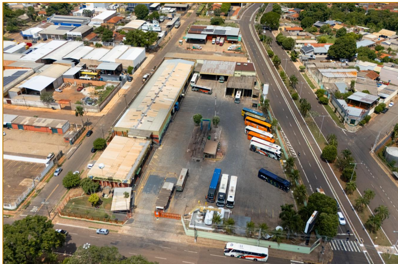
Pátio de ônibus da Empresa de Transportes Andorinha S.A, localizado na Avenida Costa e Silva, 1275, Vila Progresso, Campo Grande – MS.
